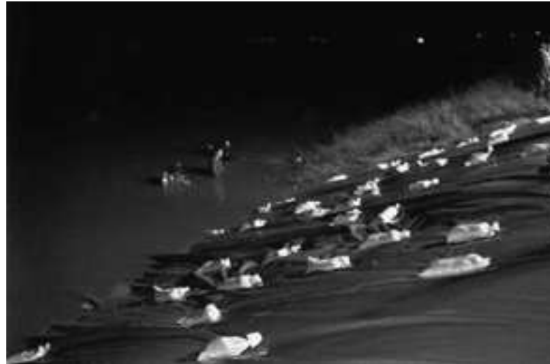
Taucher beim Auslegen von Folie und Sandsäcken
