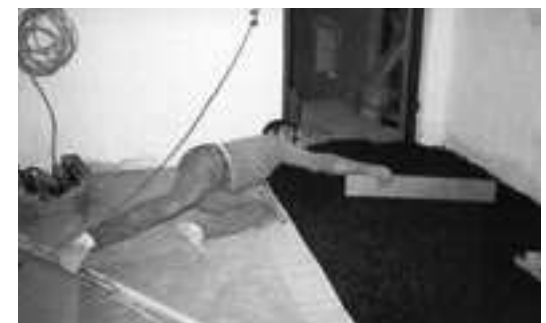
Der Umbau des Jugendraums in der Waldhofer Straße
