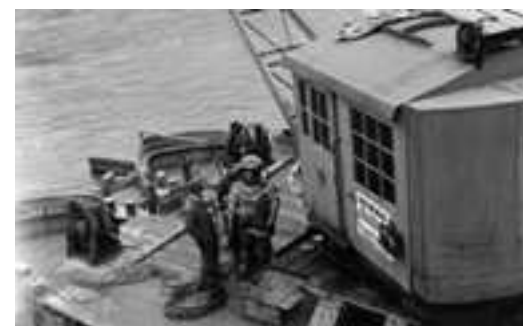
Tauchereinsatz bei Kanalisierungsarbeiten, 1929
