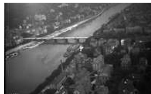
Friedrichsbrücke – davor die „neue“ Blum'sche Badeanstalt
